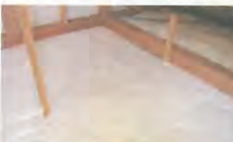
▲天井への施工
